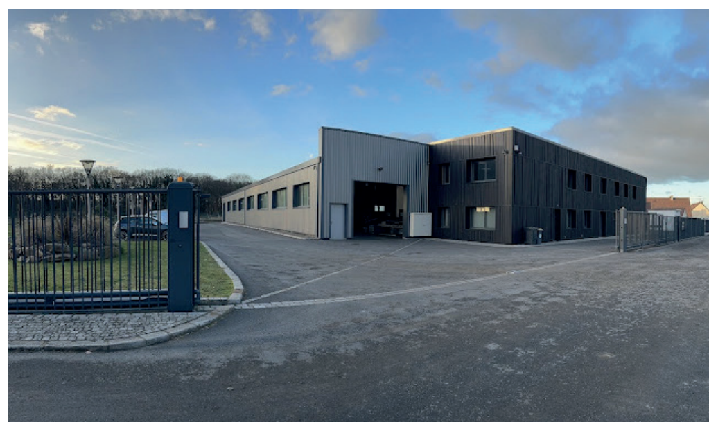
Chaudronnerie au sud du village
