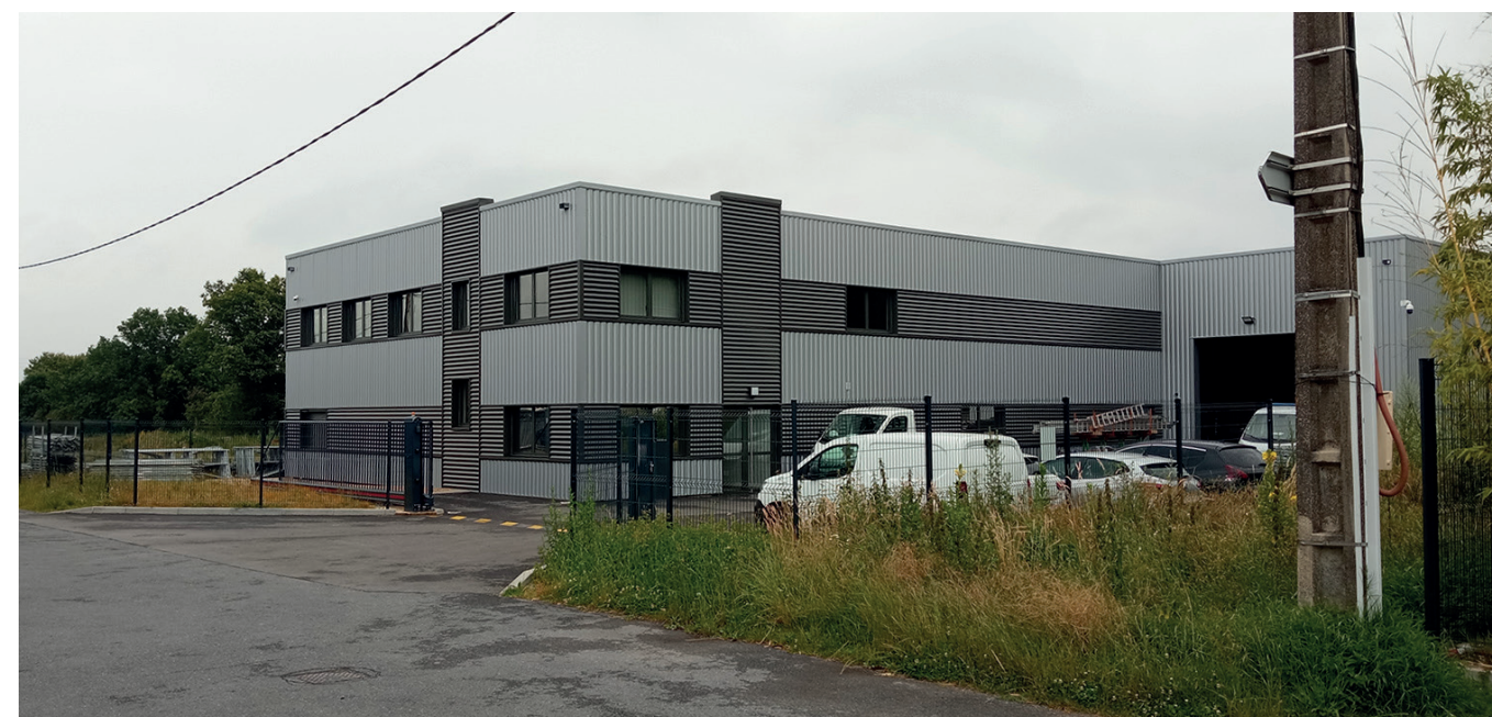
Vue sur le bâti d'activités récent en zone UE, rue du Bourdon Saint-Denis.
