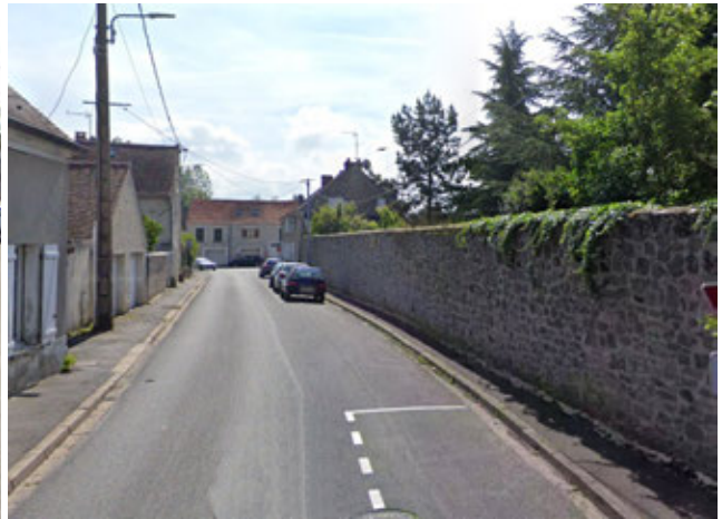
Mur en pierres
