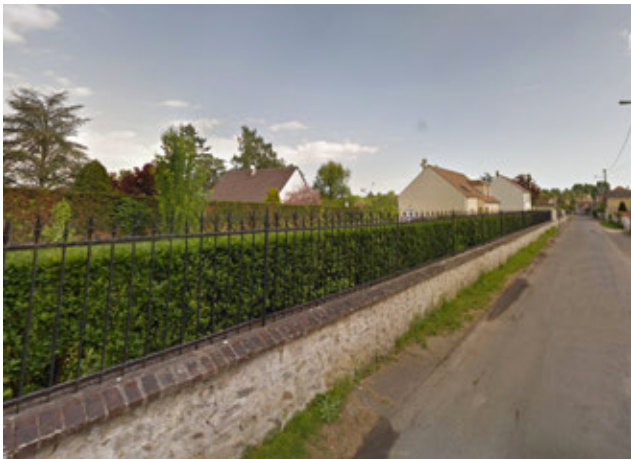
Muret en pierres.
