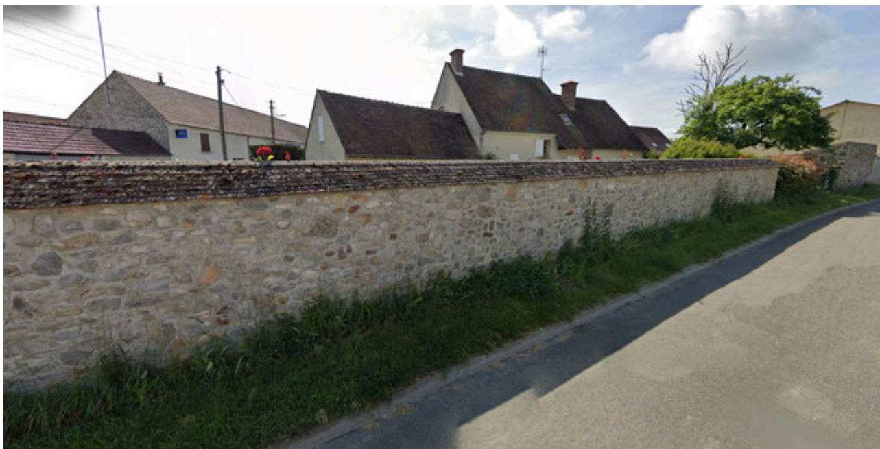
Mur en pierres
