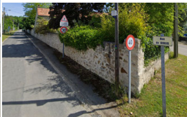
Mur et muret en pierres
