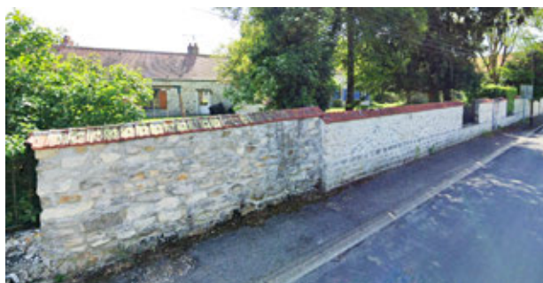
Mur en pierres
