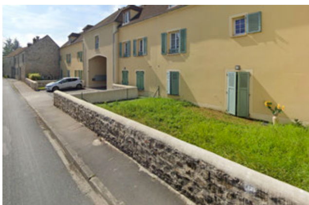
Muret en pierres
