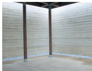
Préau aux Clayes-sous-Bois, archi. Anne Delaunay
