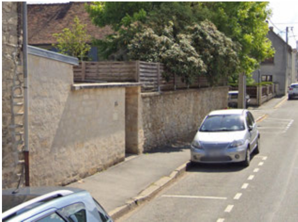
Murs en pierres
