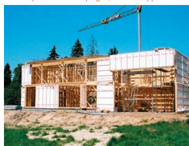
Chantier d'une maison à ossature bois
