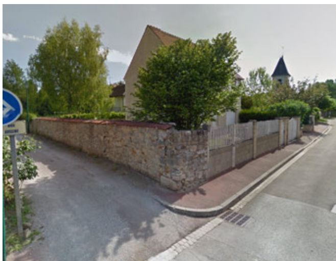
Mur en pierres
