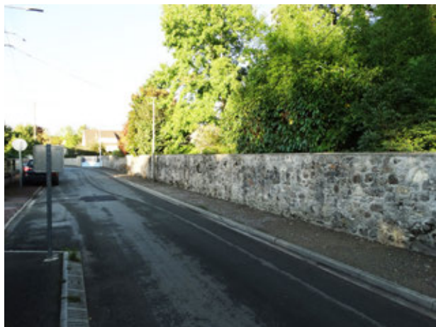
Murs en pierres
