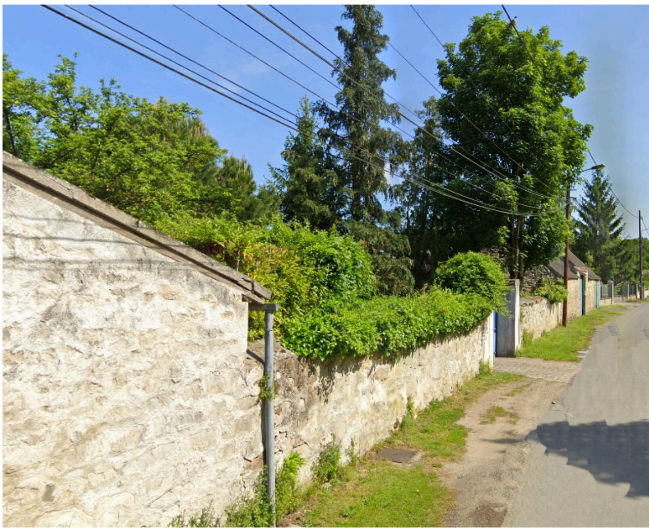
Mur en pierres
