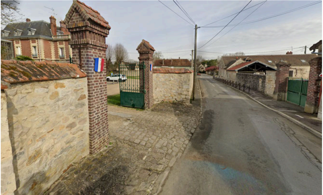
Piliers en briques rouges et murs en pierres (mairie et école)
