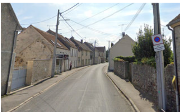
Murs en pierres
