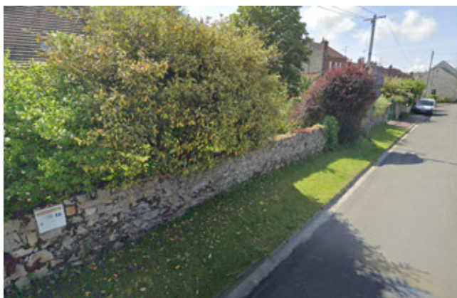
Muret en pierres
