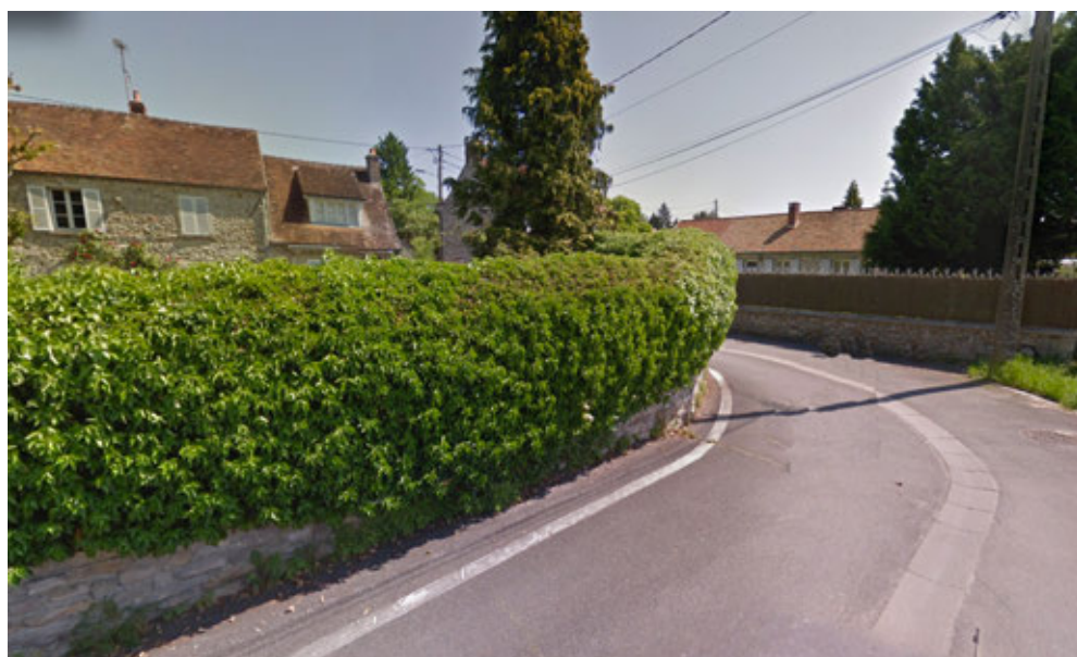
Muret en pierres
