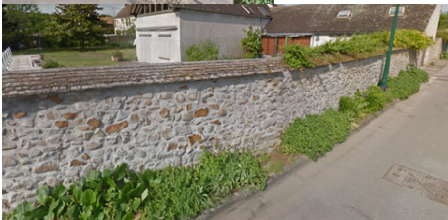
Mur en pierres face au site de l'ancienne scierie
