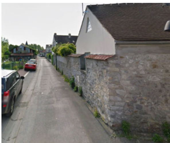
Mur en pierres
