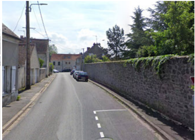
Mur en pierres
