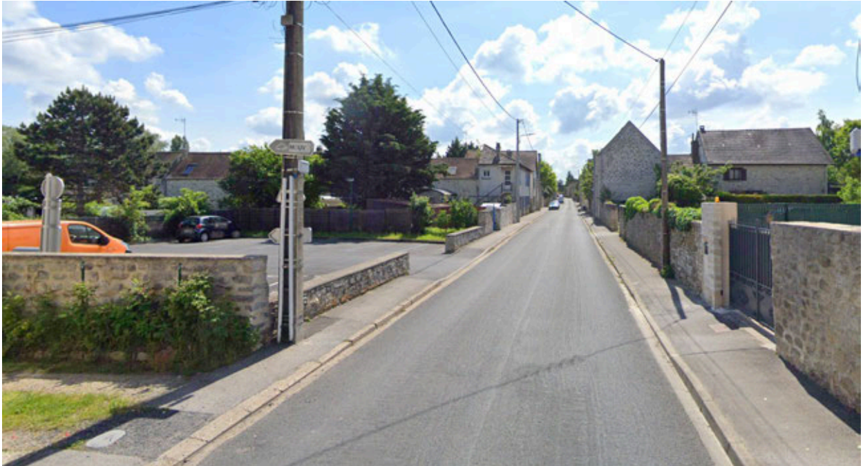
Muret et murs en pierres
