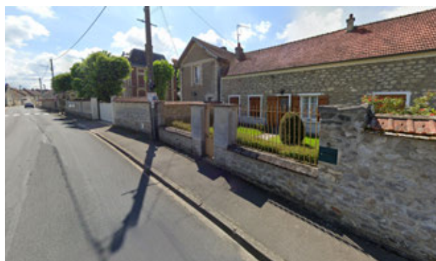
Mur en pierres
