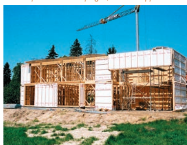
Chantier d'une maison à ossature bois
