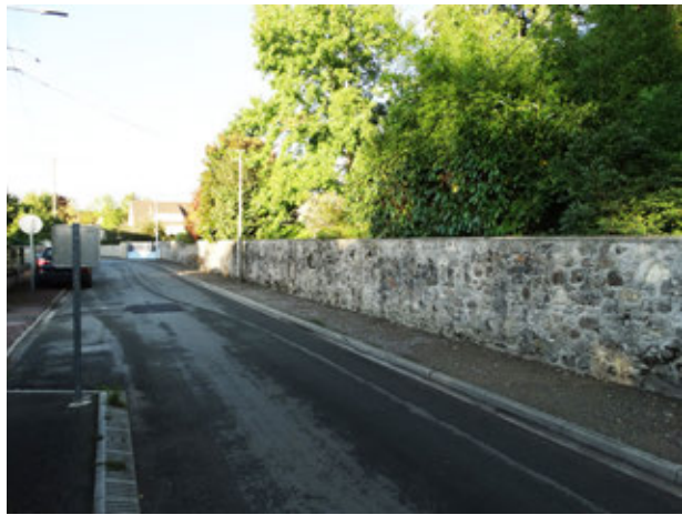
Murs en pierres
