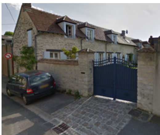
Mur et portail (rue de l'Abreuvoir)
