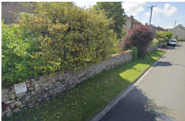
Muret en pierres
