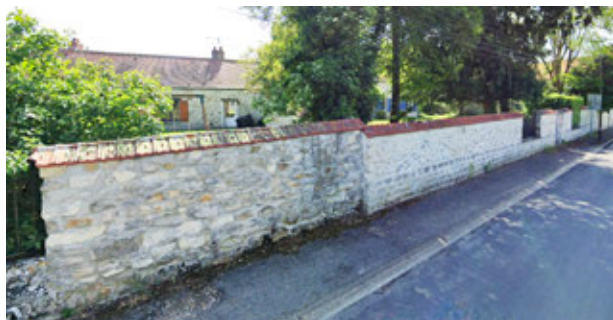
Mur en pierres
