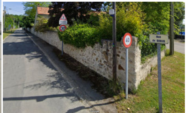
Mur et muret en pierres
