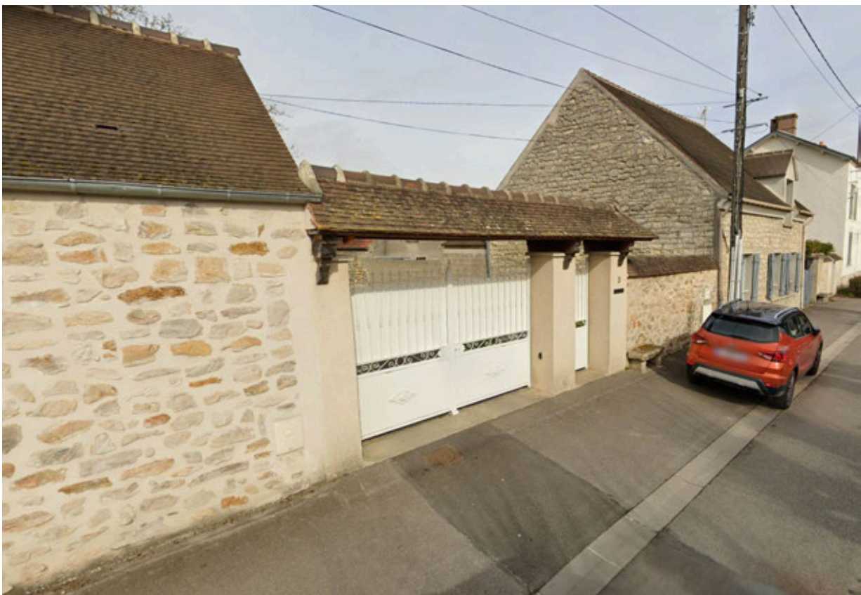
Mur en pierres
