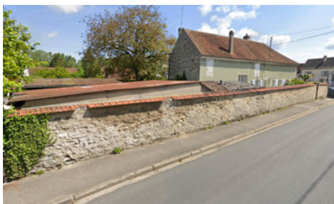
Mur en pierres face à la mairie
