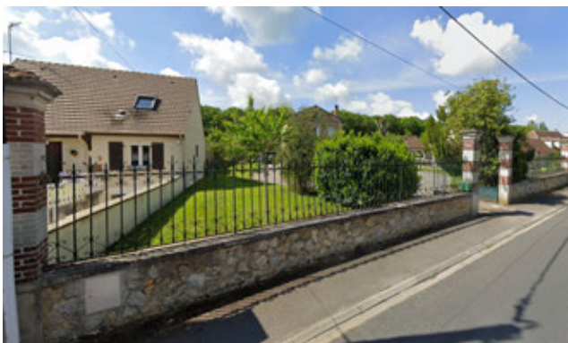
Pilier et muret en pierres et briques rouges
