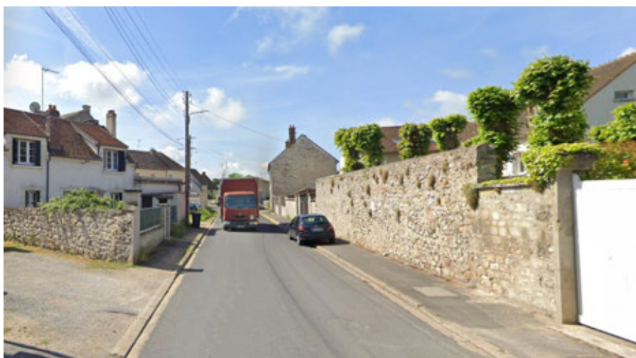
Mur en pierres
